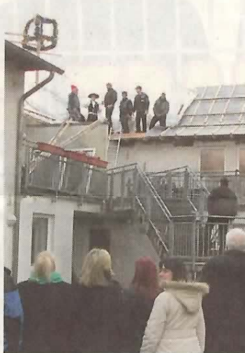
Ende November feiern die Eigentümer von acht ausgebrannten Wohnungen das Richtfest der Sanierung. Wiedereinzug ist im April.
